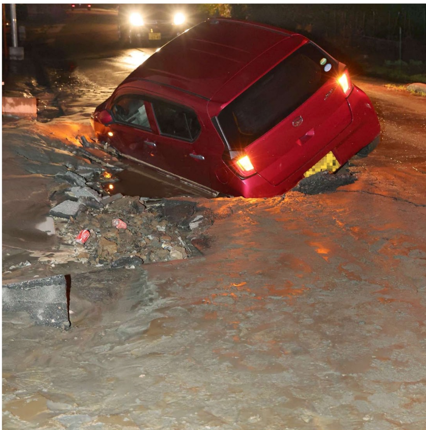
道路の陥没で身動きできなくなった乗用車。路面は水が噴き出していた。1日午後7時21分、新潟市西区鳥原
